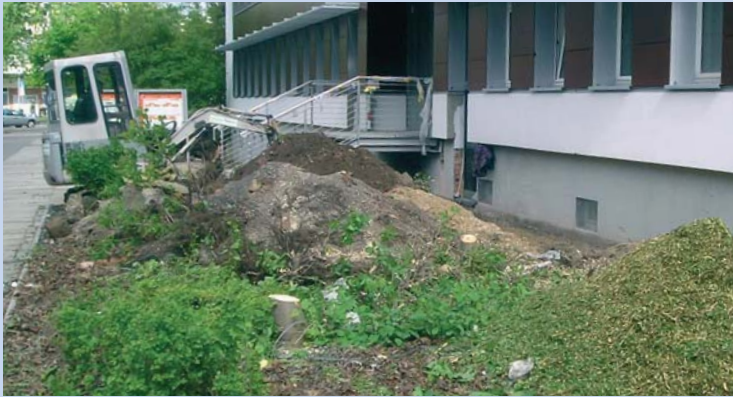
Neu gestaltet: die Außenanlagen des Bürogebäudes während...
